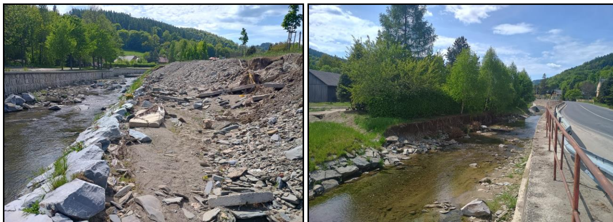
Obr. 3, 4 Různorodé a rozsáhlé poškození opevnění koryta je patrné prakticky v celém zájmovém úseku
