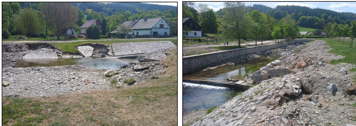
Obr. 1, 2 Destrukce spádových objektů a rozpad navazující dlažby na dolním a horním okraji zájmového úseku
